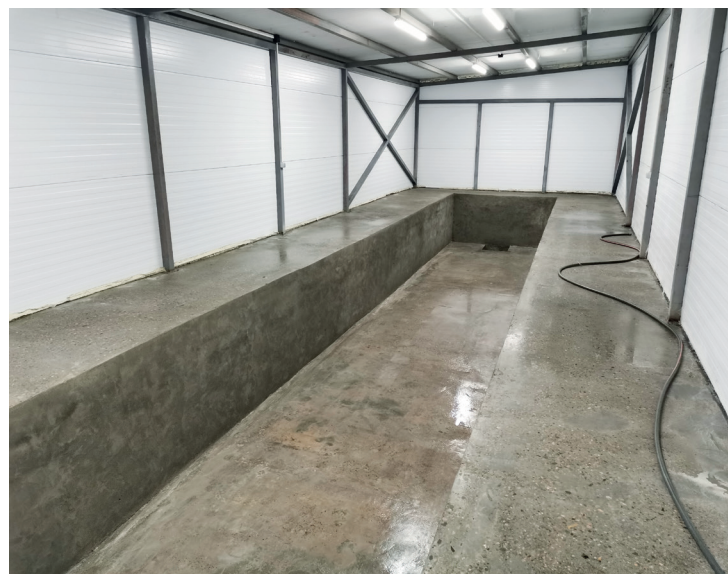
Рисунок 1. Строящийся цех ООО «МРК-2» (фото Н.Н. Игнатова)
